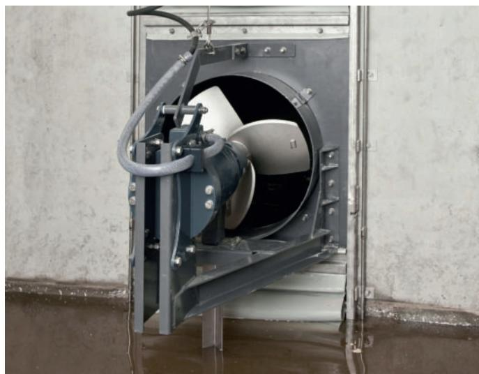
Die Ausführung stationär und höhenverstellbar eignet sich für Kanal- und Slalomsysteme. Das Rührwerk wird direkt an die Querwand mit einer Öffnung von 800 mm montiert. Der Tauchmotor ist in Edelstahl mit 20 PS (15 kW) und in Grauguss mit 20 PS (15 kW) Leistung erhältlich.
