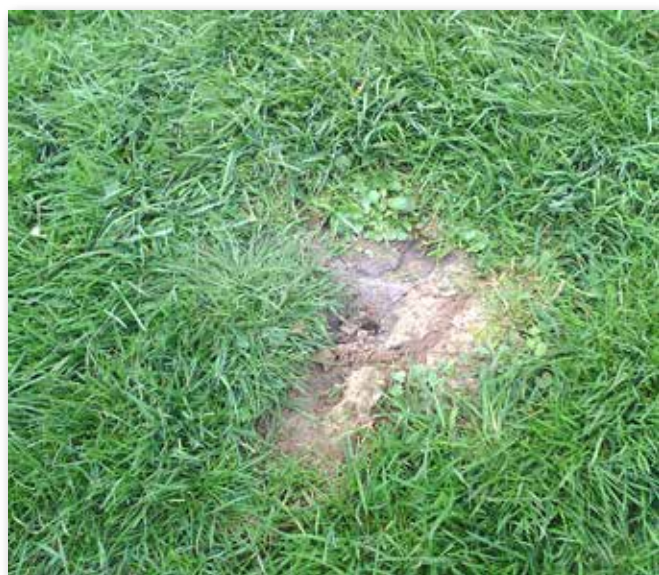
Photo 1 : trous dans la couche végétale
