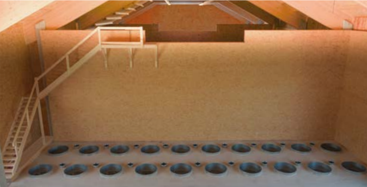
Kombi-Flex Rundballentrocknung mit einer Boxentrocknung.
