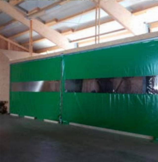
Rundballentrocknung mit Luftentfeuchter und Vorhang.
