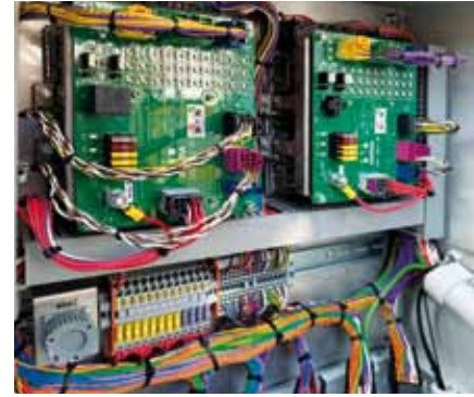
Geordneter Elektrikaufbau, mit Einzeladerbeschriftung über die volle Kabellänge. Alle Sicherungen mit Kontroll-LED
